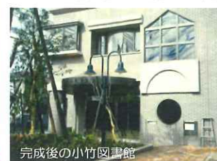
完成後の小竹図書館
